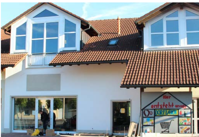
Opfenbacher Dorfmarkt in der Bauphase (Foto: WBF)
